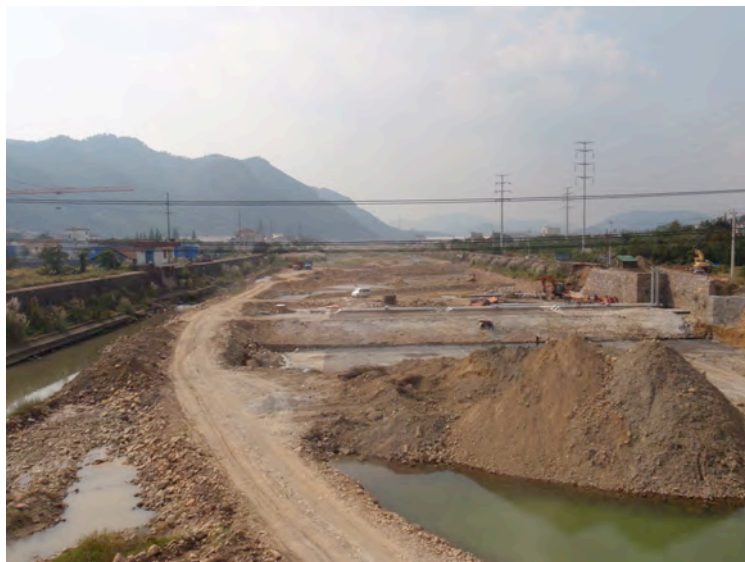
照片 5 在中游兴建的拦河坝
